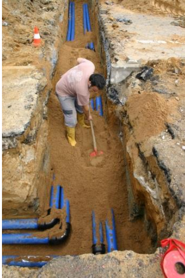
Verlegung und Verschweißen der 150 mm großen Vor- und Rücklaufleitungen vom Verteilerschacht zur Wärmezentrale im Firmengebäude.
