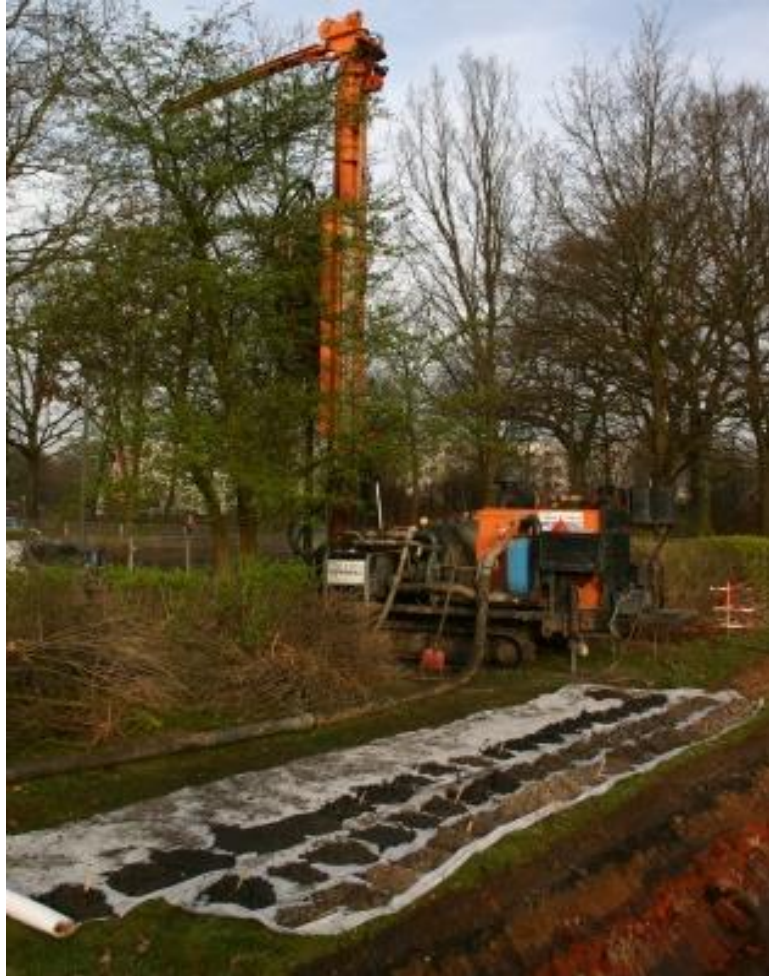
Niederbringen einer Spülbohrung bis 220 m Tiefe unter Beachtung und Schutz des alten Baumbestandes
