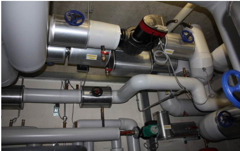
Verlegung und Verschweißen der 150 mm großen Vor- und Rücklaufleitungen vom Verteilerschacht zur Wärmezentrale im Firmengebäude.
