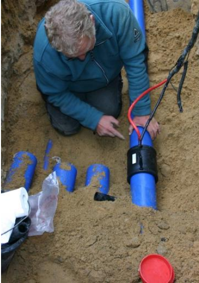
Verlegung und Verschweißen der 150 mm großen Vor- und Rücklaufleitungen vom Verteilerschacht zur Wärmezentrale im Firmengebäude.
